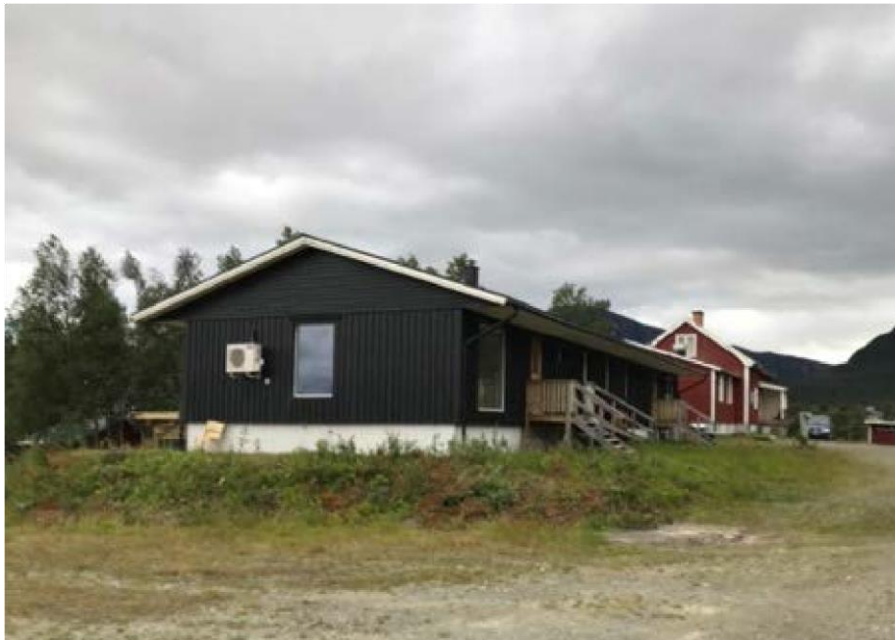
Fig 9. I förgrunden syns det ny renoverade bostadshuset och i bakgrunden syns den fd lägergården. som planeras att renoveras.
